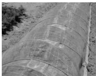
トンネルに使用例
